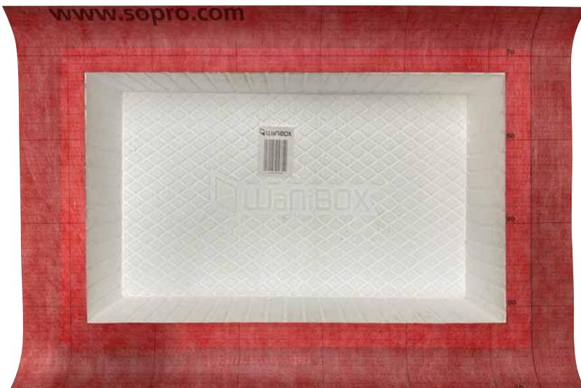
Aus der Sopro AEB® Abdichtungs- und Entkopplungsbahn 640 wird eine 50-100 mm breite Manschette für die WaNiBOX ausgeschnitten und unter Verwendung von Sopro Racofix® Montagekleber RMK 818 flächig und dicht auf der Wandung verklebt. Dabei ist darauf zu achten, dass eine geschlossene Verklebung entsteht.
